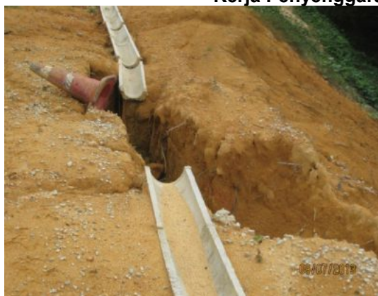
Gambar 2.32 Tanah Runtuh Berulang Akibat Hakisan Air Hujan Dan Kerja Penyenggaraan Kurang Sempurna
