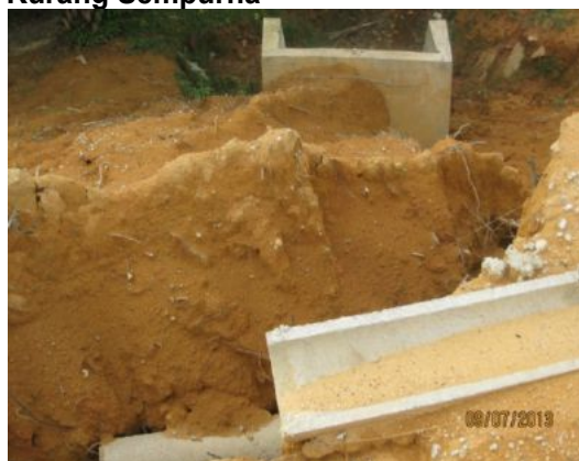
Gambar 2.32 Tanah Runtuh Berulang Akibat Hakisan Air Hujan Dan Kerja Penyenggaraan Kurang Sempurna
