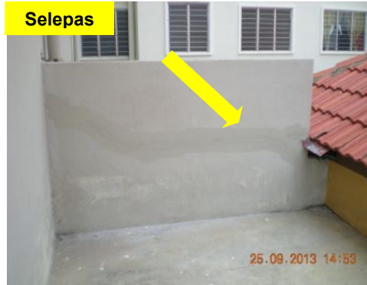
Gambar 1.23 Keretakan Pada Tembok Telah Dibaiki
