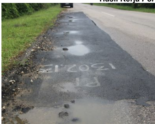
Hasil Kerja Porthole Tidak Kemas
