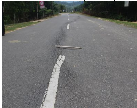
Gambar 2.11 Cacat Permukaan (Lekukan)
