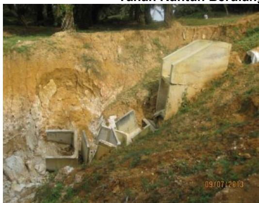
Gambar 2.34 Tanah Runtuh Berulang Akibat Hakisan Air Hujan
