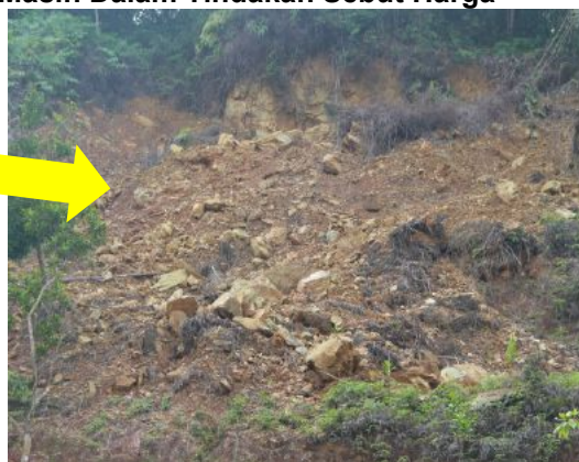
Gambar 2.39 Tanah Runtuh Belum Disenggara Dan Masih Dalam Tindakan Sebut Harga
