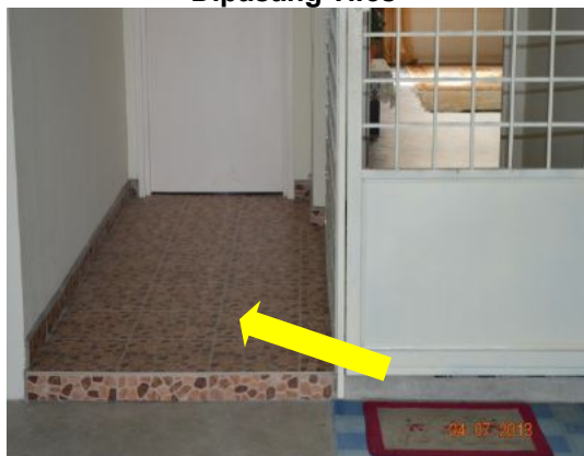
Gambar 1.4 Rumah Diubahsui Dan Dipasang Tiles
