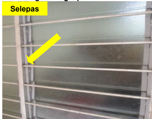
Gambar 1.37 Bingkai Tingkap Telah Ditukar
