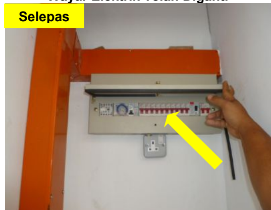
Gambar 1.53 Wayar Elektrik Telah Diganti
