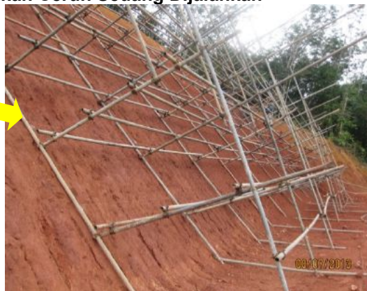
Gambar 2.38 Kerja Soil Nailing Bagi Menstabilkan Cerun Sedang Dijalankan
