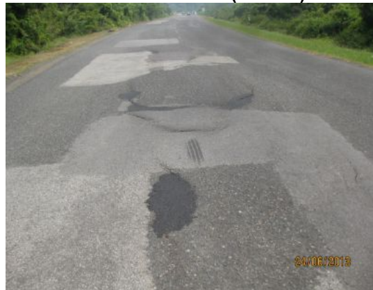
Gambar 2.12 Cacat Permukaan (Alunan)
