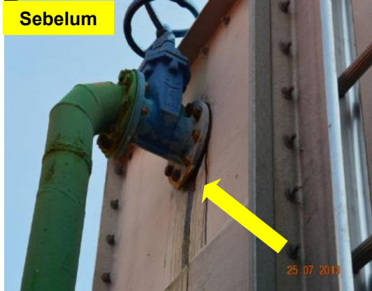
Gambar 1.32 Kesan Lelehan Air Pada Tangki Air
