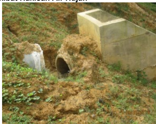
Gambar 2.34 Tanah Runtuh Berulang Akibat Hakisan Air Hujan
