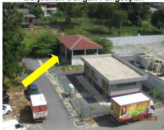
Gambar 1.56 Lokasi Rumah Sampah Yang Berjauhan Dengan Pangsapuri
