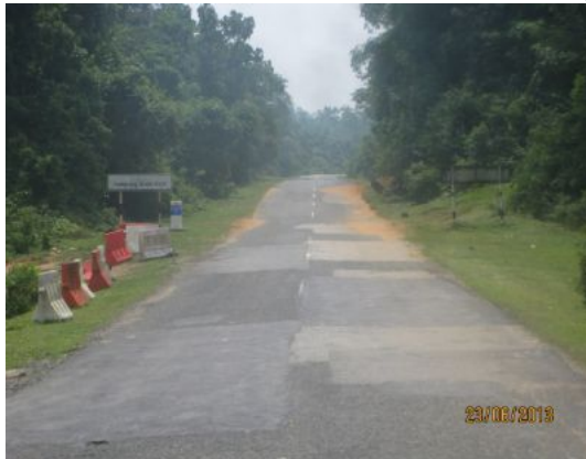
Gambar 2.19 Kerosakan Berulang Di Lokasi Yang Sama
