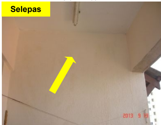
Gambar 1.29 Keretakan Dan Kesan Resapan Air Telah Dibaiki
