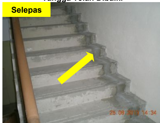
Gambar 1.19 Keretakan Pada Anak Tangga Telah Dibaiki
