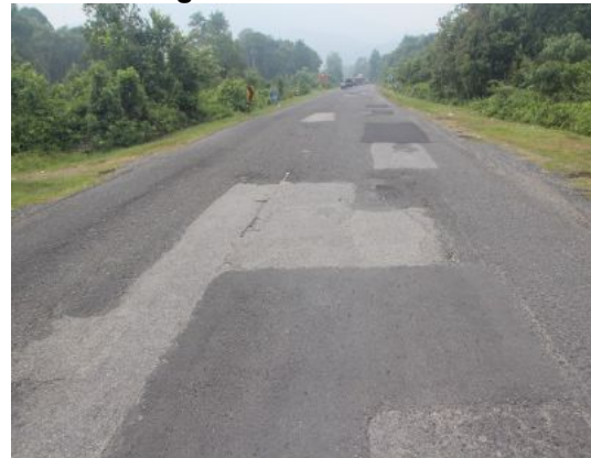
Gambar 2.19 Kerosakan Berulang Di Lokasi Yang Sama
