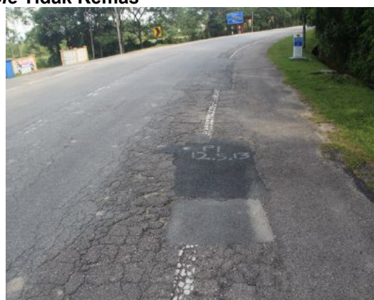
Hasil Kerja Porthole Tidak Kemas
