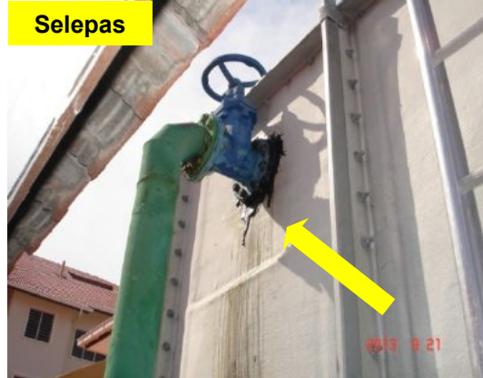
Gambar 1.33 Kesan Lelehan Air Telah Dibaiki
