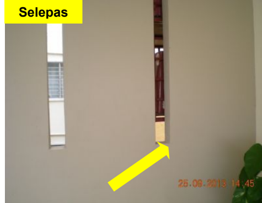
Gambar 1.21 Keretakan Dinding Telah Dibaiki
