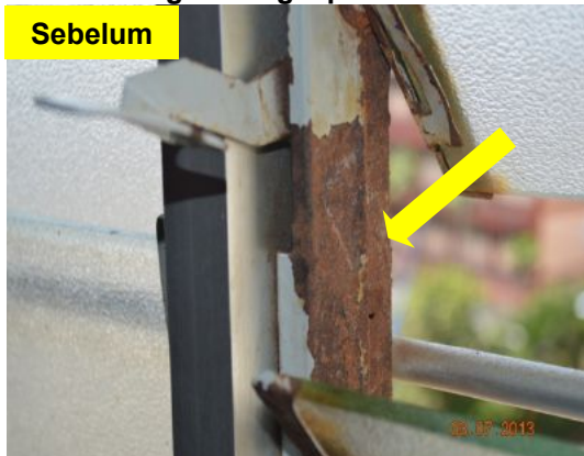
Gambar 1.36 Bingkai Tingkap Berkarat
