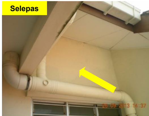
Gambar 1.27 Keretakan Dan Kesan Resapan Air Telah Dibaiki
