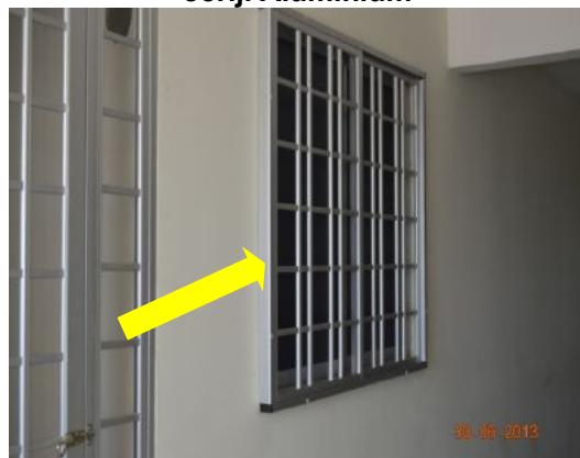
Gambar 1.5 Tingkap Ditukar Dan Dipasang Jeriji Aluminium
