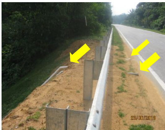
Gambar 2.32 Tanah Runtuh Berulang Akibat Hakisan Air Hujan Dan Kerja Penyenggaraan Kurang Sempurna
